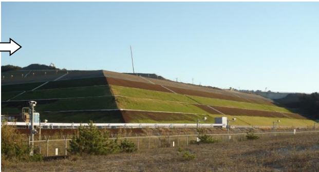
2018年11月15日。保安林を伐採し、5段まで盛り土が積み上がった。
